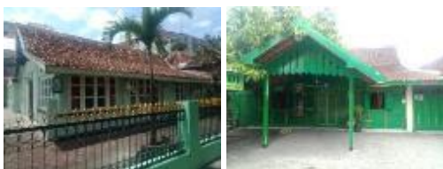
Gambar 2. Beberapa Bangunan Indis/Kolonial di Kampung Purbonegaran
