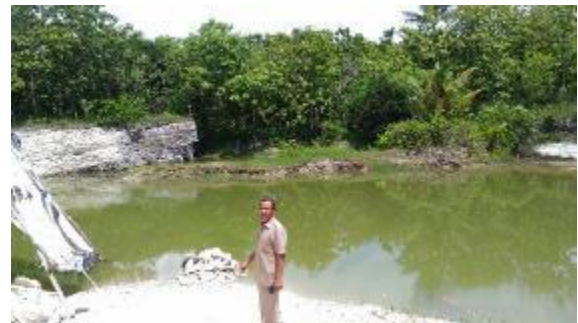
Gambar 1. Kondisi Eksisting Embung Pule (Sumber: Survey, 2020)
