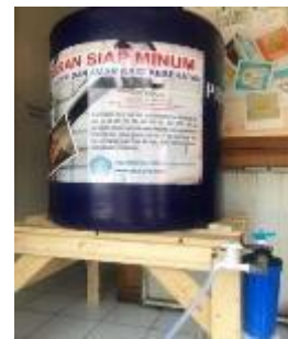
Gambar 1. Instalasi PAB Tirtajaya
